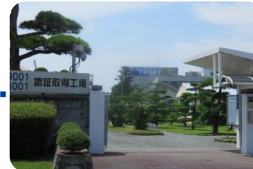
Toray (Ehime Plant)
