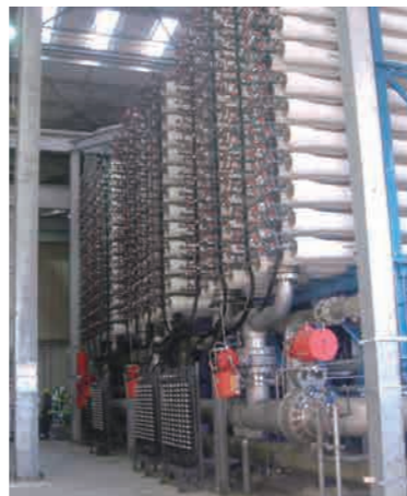
東レのRO膜エレメントを用いた アフリカ初の10万m 3 /日級 ハンマ海水淡水化プラント (アルジェリア) ※膜エレメントは2009年度 ものづくり大賞特別賞受賞 Photo: GE Water & Process Technologies Hamma Seawater Desalination Plant, first in the 100,000 m 3 /day class in Africa, using Toray's RO membrane elements (Algeria) ※The membrane elements won the Monodzukuri Nippon Grand Award, Special Prize in 2009
